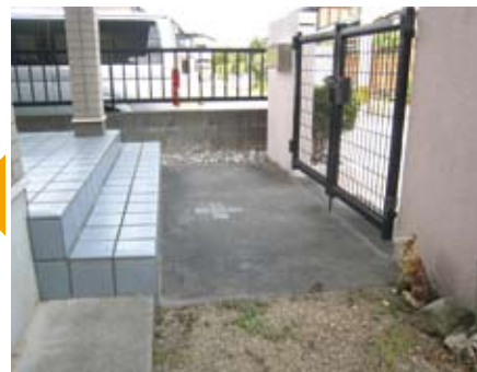
玄関先の改修前
